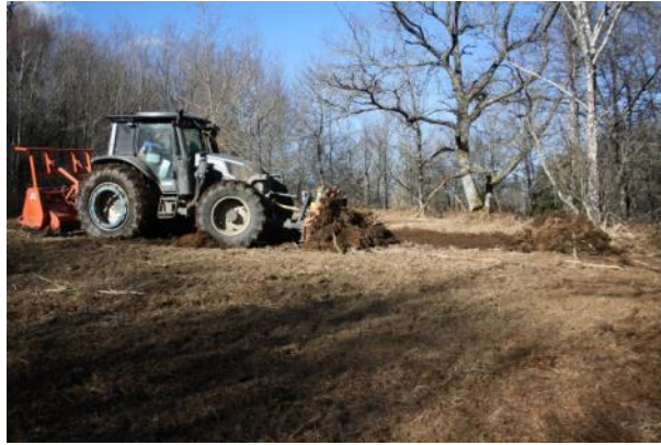
Travaux d'étrepage en cours
