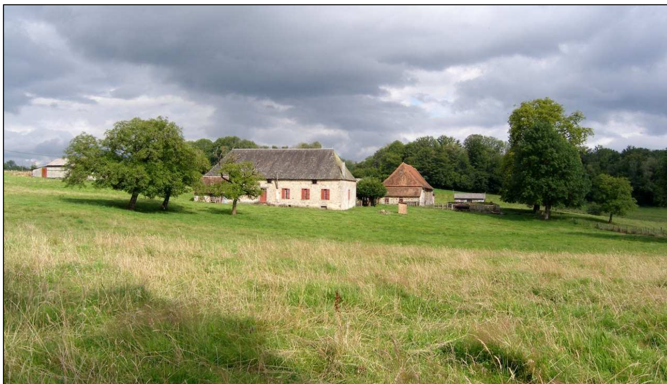
Cliché : bâti traditionnel du sud Haute-Vienne.
